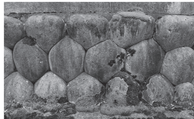
図1 玉石の亀甲積み
