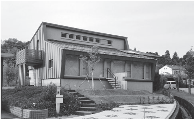
写真1 前沢パッシブハウスの外観
