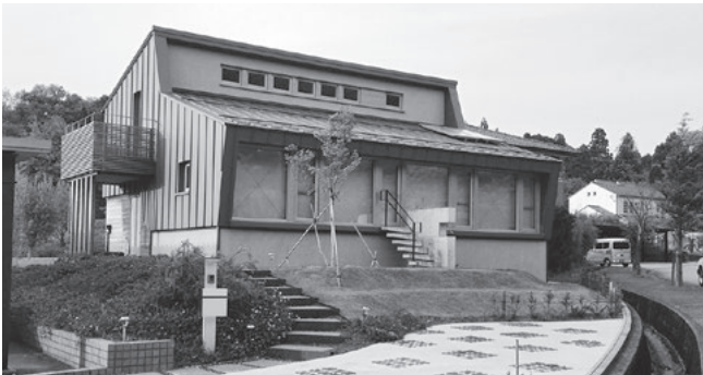
写真1 前沢パッシブハウス
