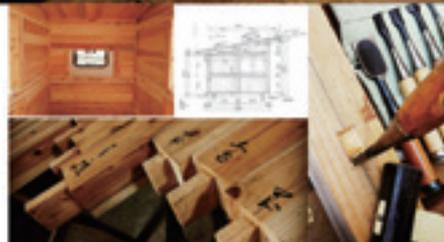
建築デザイン、セルフビルド／木組み(伝統木構造)、手刻み、杉、アテ(能登ヒバ)／h1740×w2450×d1460mm
