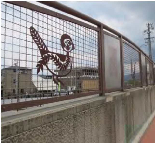
図13：丸山橋（長野県岡谷市）、筆者撮影
